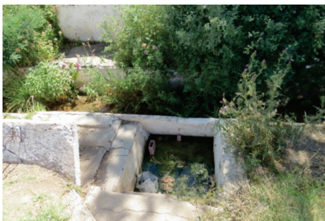
Рис. 4. Текущее состояние Майлибайского ирригационного канала и соответствующих гидростов
